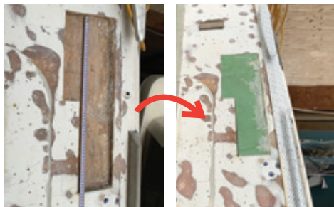
Een rotte plek in het dek wordt zo hersteld
