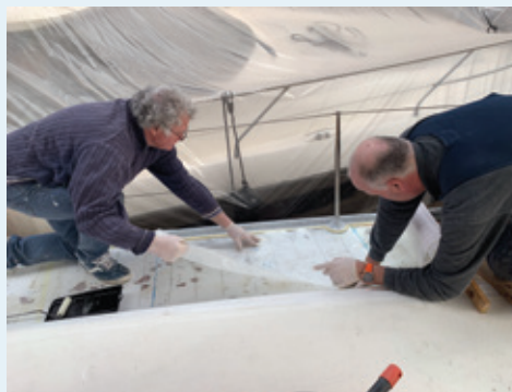
Aanbrengen epoxy, 2 lagen glasvezel en 1 laag peelply
